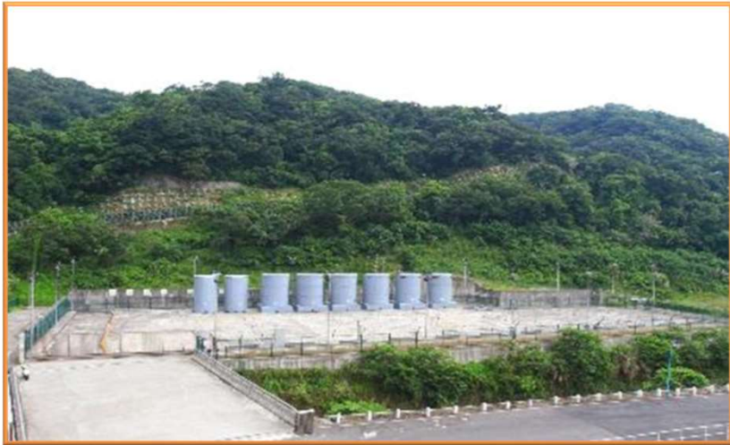
場址現況照片(護箱中尚未貯存用過核子燃料)
