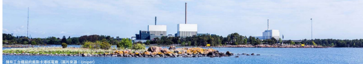
擁有三部機組的奧斯卡港核電廠 (圖片來源: Uniper)
