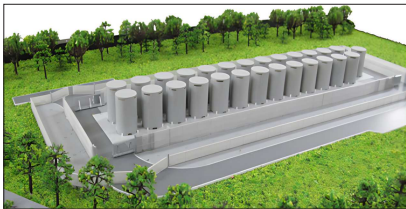
預定設置27組混凝土護箱，每組護箱容裝87束用過核燃料，共計可貯存2,349束用過核燃料。
