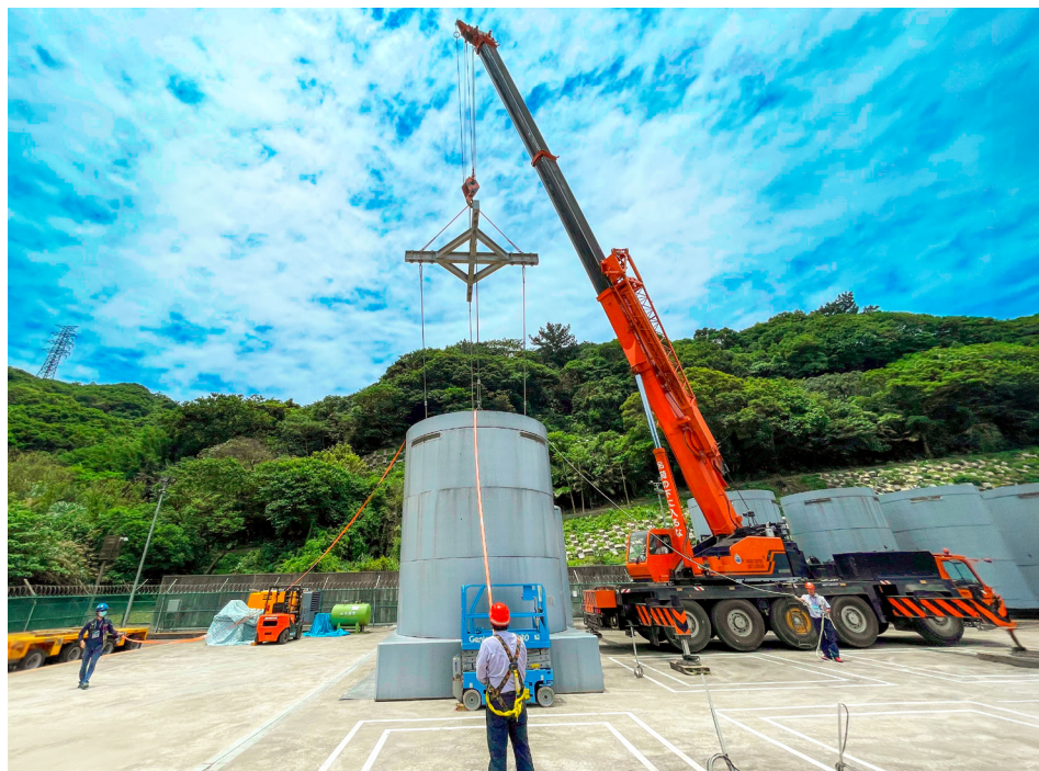
外加屏蔽 AOS 吊裝作業
