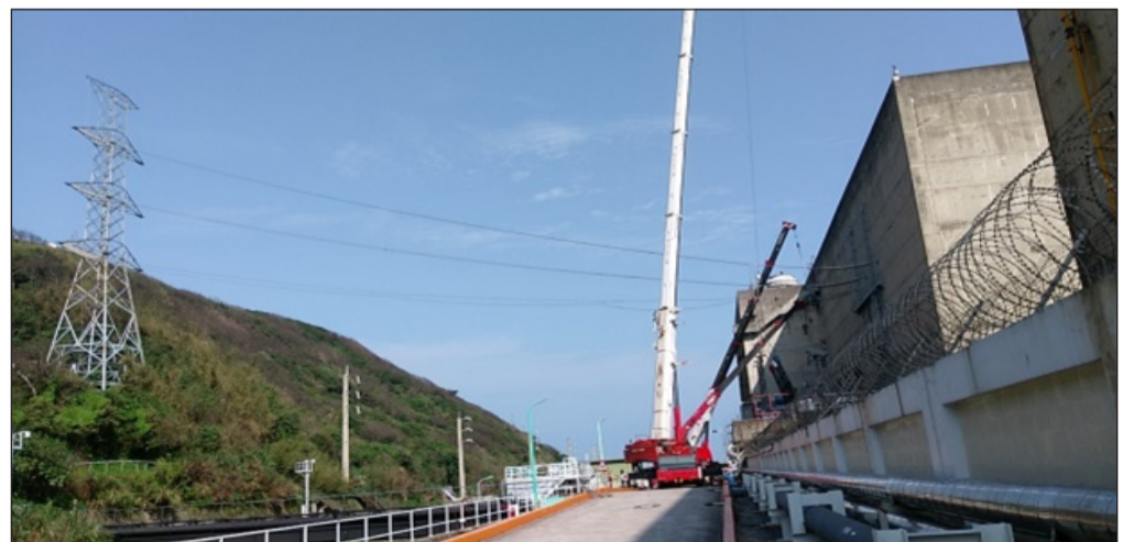
連絡鐵塔施工現場。
