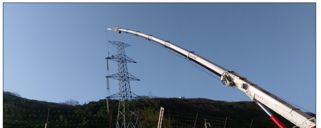
G1T1至1號機主變壓器間輸電線、變壓器端礙子連及鐵器組件拆除施作。
