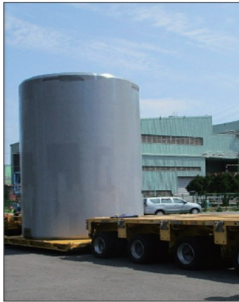
傳送護箱吊裝作業。
