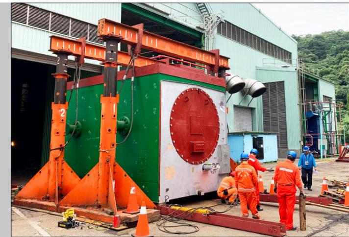
發電機定子(綠色)以門式吊車移出氣渦輪機廠房。
