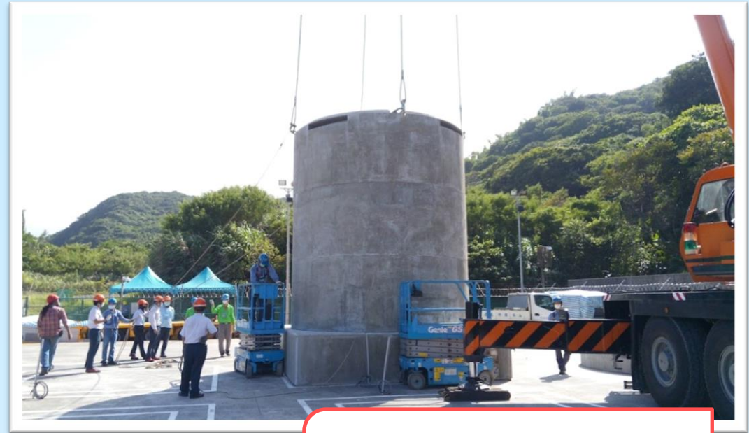
外加屏蔽吊裝作業
