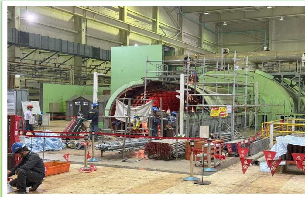
主發電機外殼切割中
